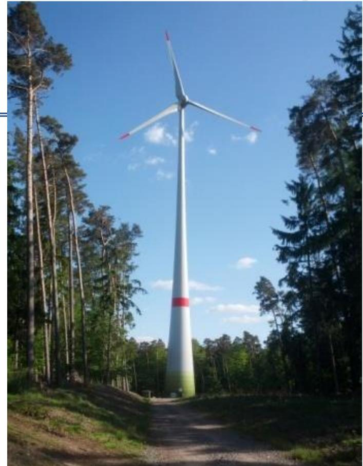
Bild: ©Pro Windkraft Niedernhausen : E-82, 2MW, Nabenhöhe 138m auf dem Binselberg, Groß-Umstadt
